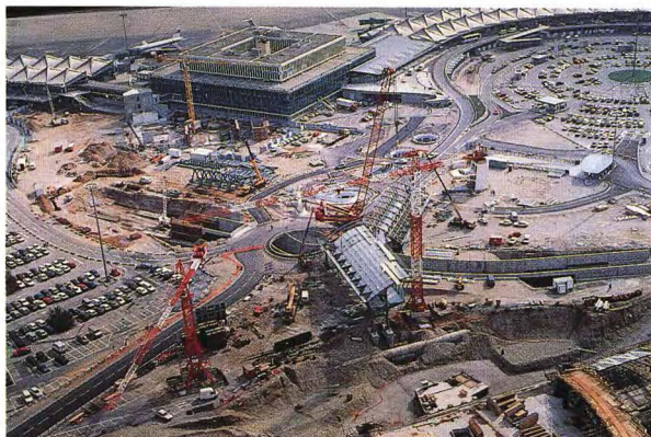
Vista general del aeropuerto Lyon-Satolas y estación del TGV en construcción.
